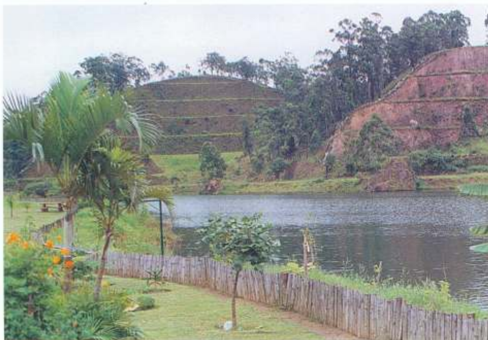
Taludes recuperados pelo projeto guarapiranga
