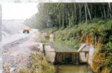
Tanques de clarificação em série no sistema de drenagem
