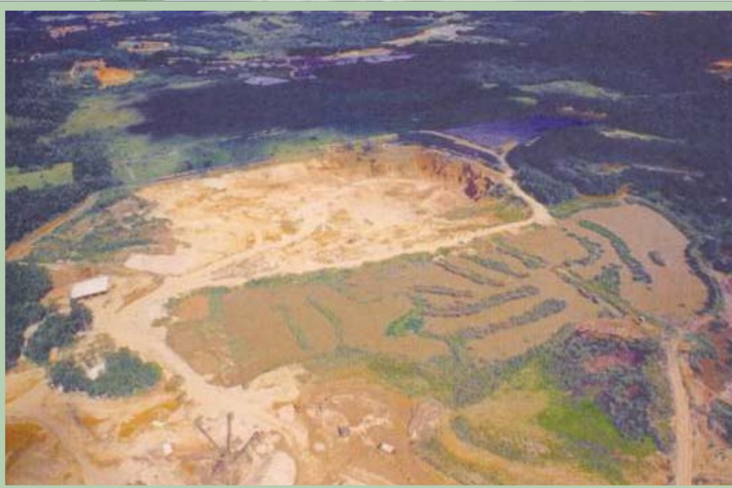
Recuperação da área em andamento
