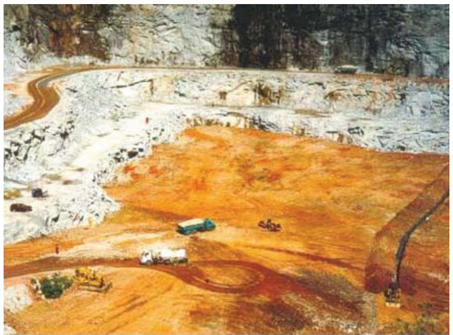
Vista do aterro: na parte baixa a direita à construção do dreno.
