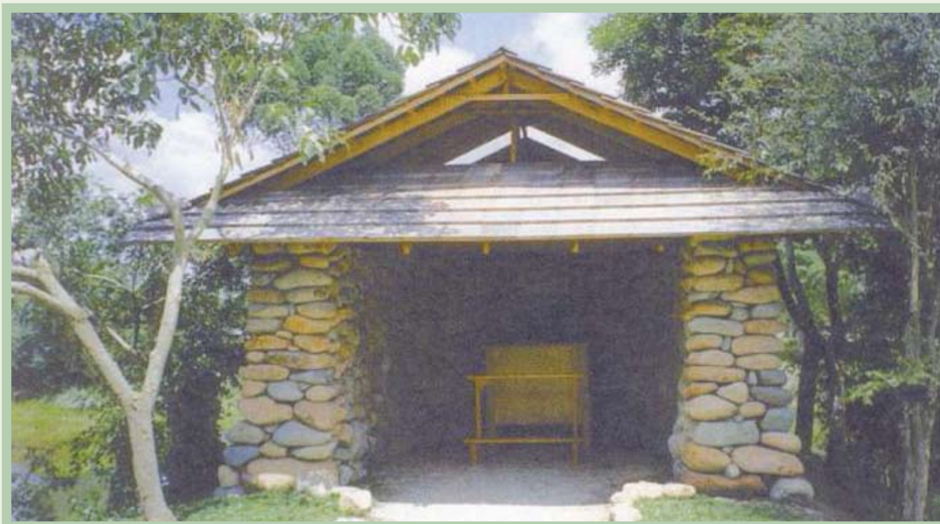
Capela em construção
