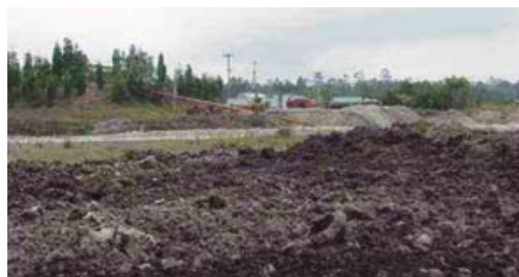
Painel lavrado, aterrado com rejeitos e redistribuição de estéril que recebe cobertura com solo vegetal previamente estocado.
