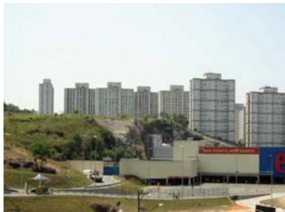
Hipermercado implantado recentemente na cava de antiga pedreira no bairro do Jaguaré no município de São Paulo.
