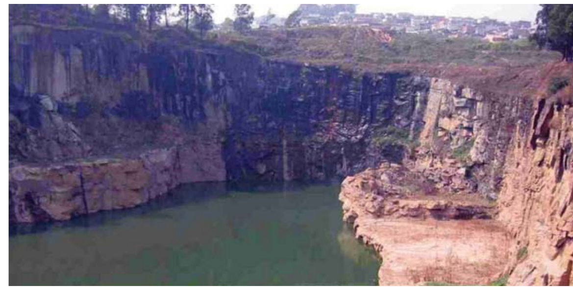
Cava da Pedreira Lageado em São Paulo, parcialmente inundada e já utilizada pela Prefeitura Municipal de São Paulo para contenção de cheias do córrego Itaquera.
