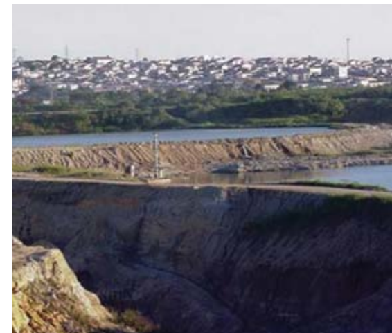
Cava do porto Caravelas que poderá ser utilizada como “piscinão” para contenção de cheias do Rio Tietê em Mogi das Cruzes.
