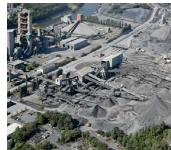
Cimescaut Materiais - Planta de britagem e peneiramento em primeiro plano.
