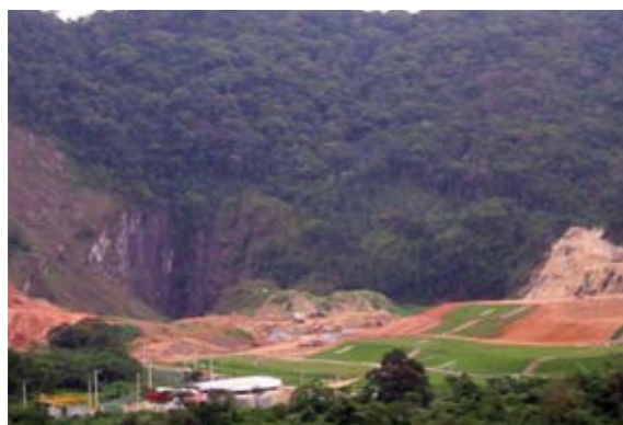
Aterro sanitário na propriedade da Firpavi de Santos que futuramente avançará também sobre a cava da pedreira.
