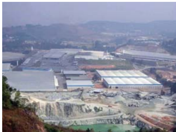
Área de antigas bacias de decantação de rejeitos argilosos da Sarpav em Barueri ocupada atualmente por galpões para usos industriais e comerciais.
