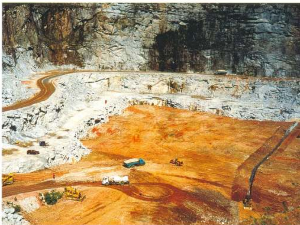
Vista do aterro: na parte baixa à direita a construção do dreno
