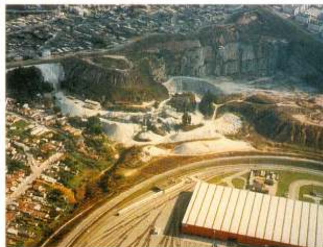
Vista aérea da Pedreira Itaquerã. À direita, pátio de manobras do metrô.
