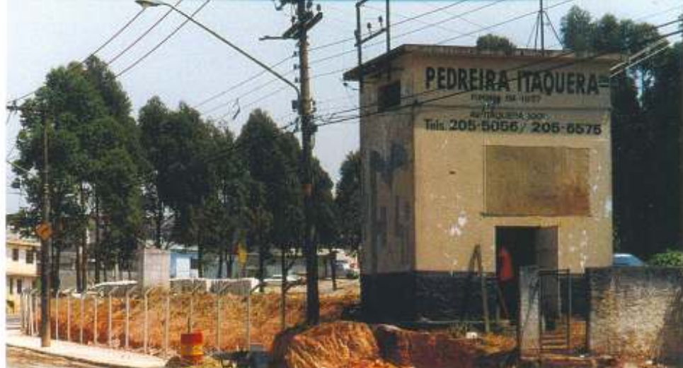
Entrada para o aterro
