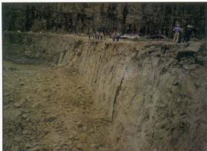
Vista da bancada após o desmonte
