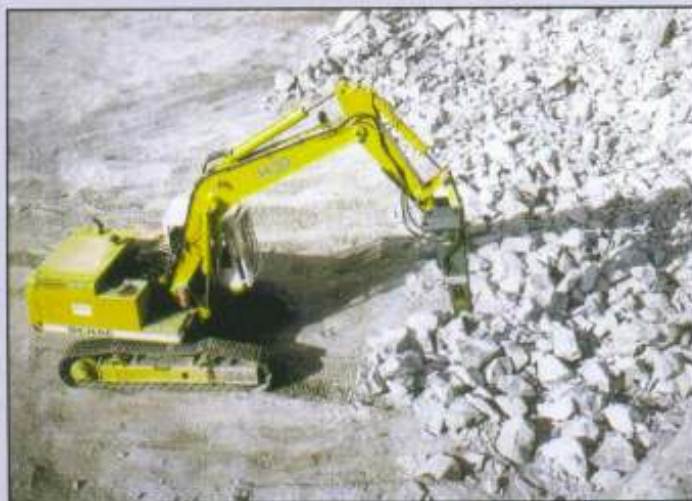
Rompedor hidráulico em operação
