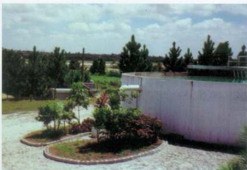
Estação de Tratamento de Águas, que devolve à natureza a água em superior qualidade do que inicialmente captada para a utilização no processo produtivo
