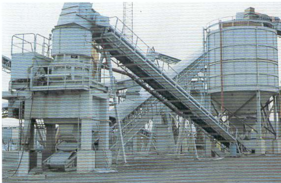
Um britador Hydrocone com um silo alimentador, monitores de nível e ASR Plus.
