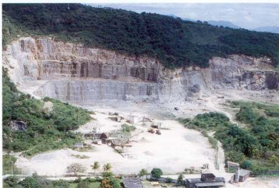
Pedraleza - Pedra Fortaleza Ltda
