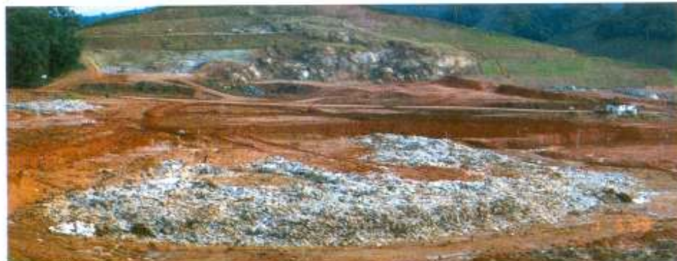
Lixão em processo de transformação em aterro sanitário
