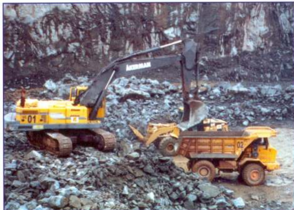
Escavadeira trabalha sobre pilha de material detonado
