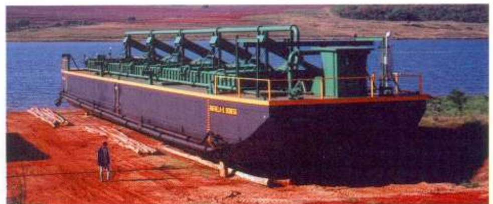
Embarcação de grande porte em construção para extração de areia no leito do rio Grande
