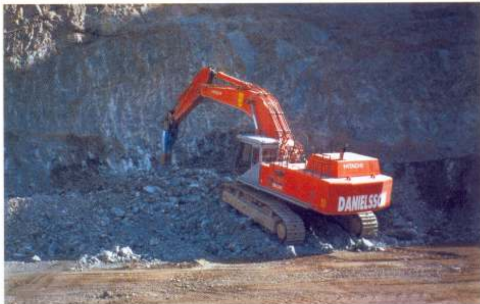
Rompedor mecânico em atividade na pedreira da Skanska em Astorp
