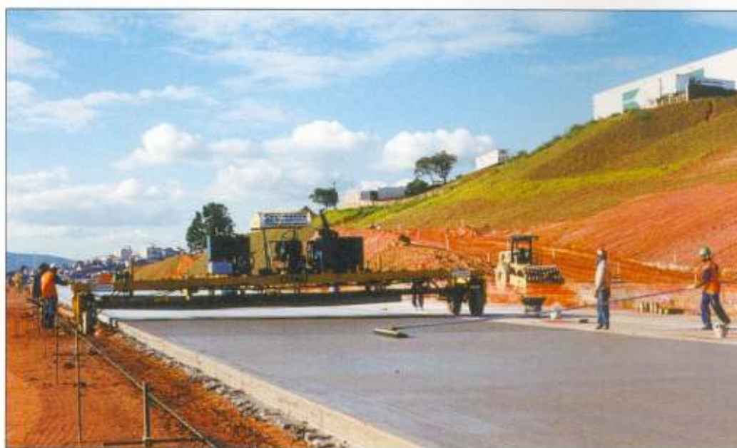
Operários fazem acabamento após passagem da pavimentadora
