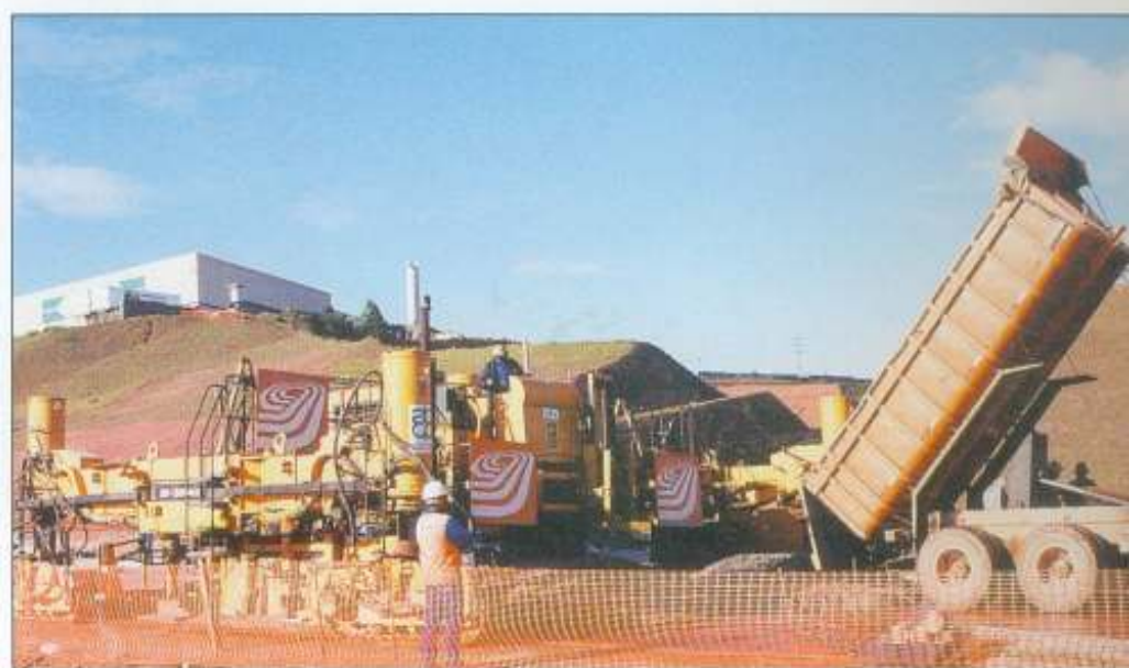
Basculante descarregando concreto em frente à pavimentadora
