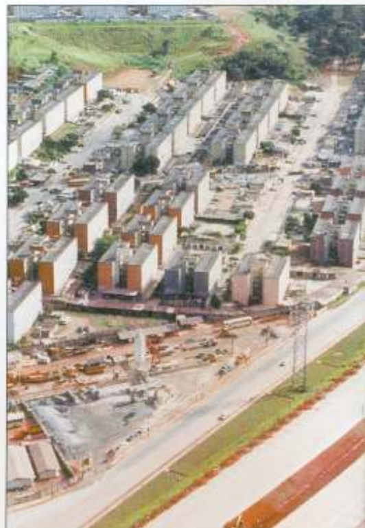
Pavimento de concreto no trecho Raposo Tavares x Castelo Branco
