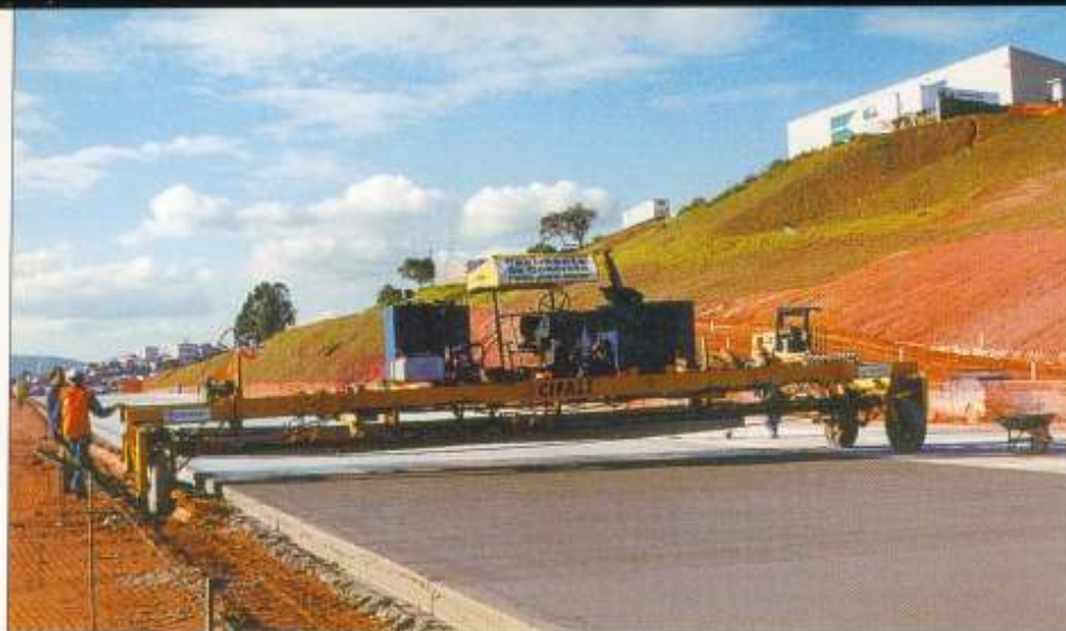
Máquina aspergidora do produto para cura do concreto
