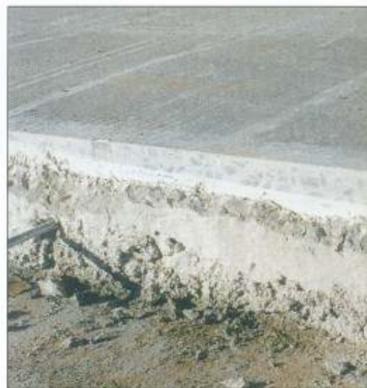
Detalhe do pavimento de concreto
