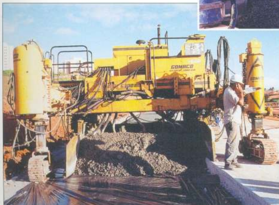
Outra pavimentadora executando o acostamento
