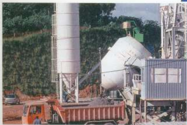
Descarga do concreto em caminhões basculantes
