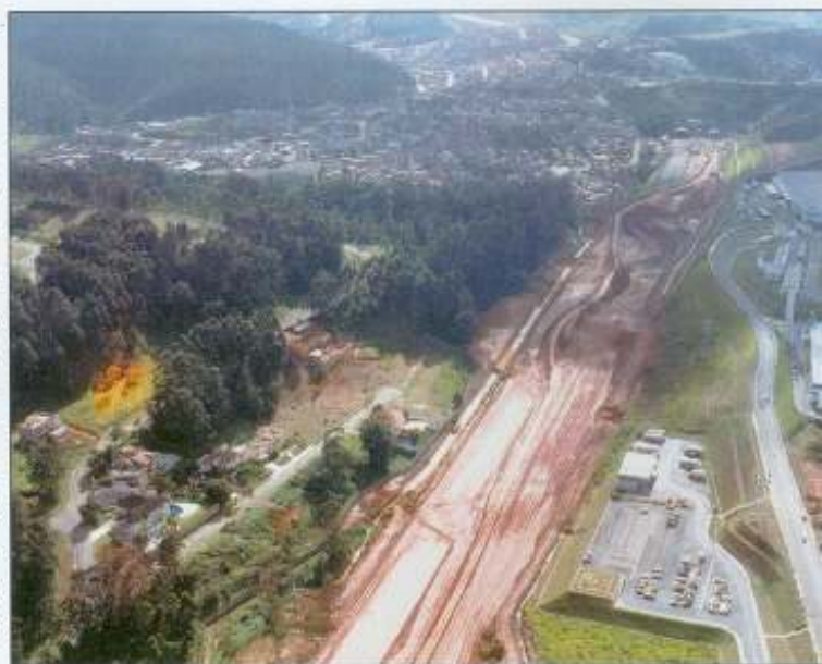
Trecho em construção entre a Castelo Branco e Bandeirantes
