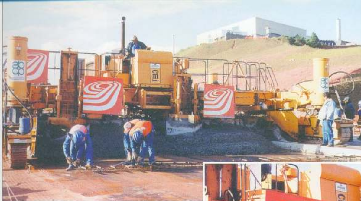
Máquina pavimentadora em ação
