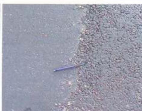
Foto 5: Detalhe de revestimento asfáltico: à esquerda faixa IVb do Instituto do Asfalto com asfalto modificado por polímero (Betuflex) e à direita SMA
