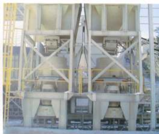
Linha de britagem areia p/ argamassa
