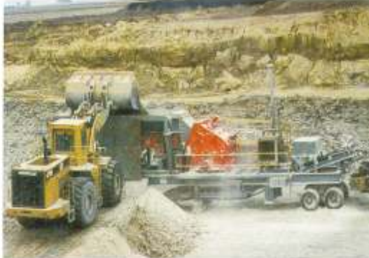
Vista da área de lavra com o britador móvel
