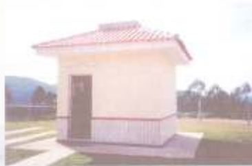
Licenciamento mineral e ambiental da engarrafadora de água mineral da VCN - Empresa de Mineração Ltda. Biritiba-Mirim (SP)
