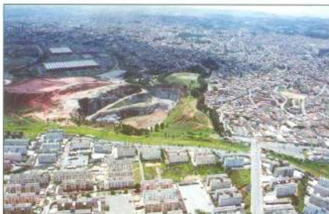
Figura 1 – Pedreira de agregados cercada por aglomerado urbano
