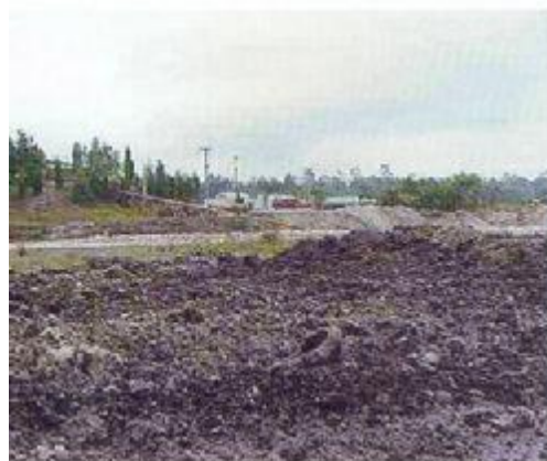
Painel lavrado, aterrado com rejeitos e redistribuição de estéril que recebe cobertura com solo vegetal previamente estocado.
