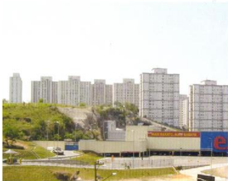
Hipermercado implantado recentemente na cava de antiga pedra no bairro do Jaguaré no município de São Paulo.
