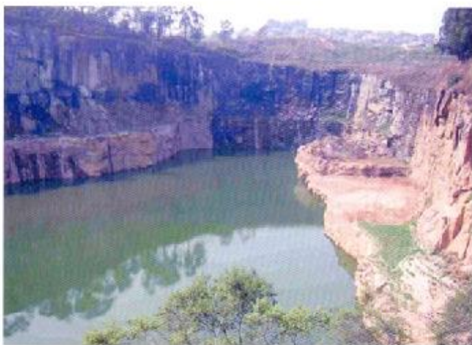
Cava da pedra Lageado em São Paulo, parcialmente inundada e já utilizada pela Prefeitura Municipal de São Paulo para contenção de cheias do córrego Itaquera.
