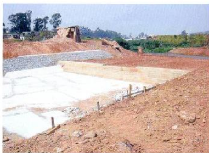
Extravasar construído pela Prefeitura Municipal de São Paulo para direcionar as águas provenientes das cheias do córrego Itaquera para o pisciñão construído na pedra Lageado.
