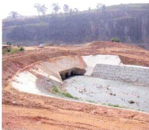
Obras civis do sistema de regularização de vazão do córrego Itaquera que direciona as cheias deste córrego para a antiga cava da pedra Lageado, atual "pisciñão" do Itaquera.
