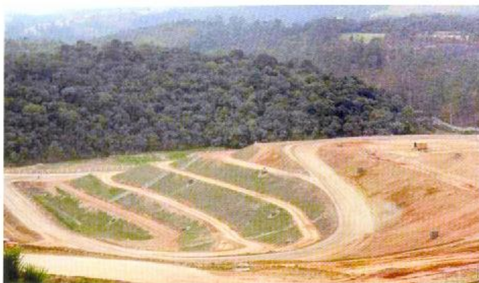
Aterro Sanitário implantado na propriedade da Firpavi na divisa de Guarulhos com São Paulo em área ocupada anteriormente por mineração de quartzo para produção de areia para construção civil.
