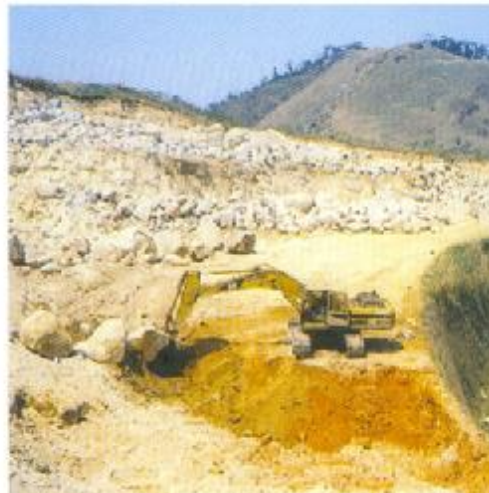
Retro-escavadeira faz decapeamento lateral e seleciona material
