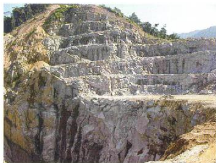
Vista das bancadas da pedra Massaguaçu em Caraguatatuba resultantes do retaludamento do paredão antes existente.
