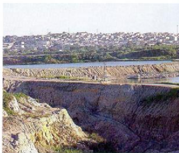
Cava do porto Caravelas que poderá ser utilizada como "pisciñão" para contenção de cheias do Rio Tietê em Mogi das Cruzes.
