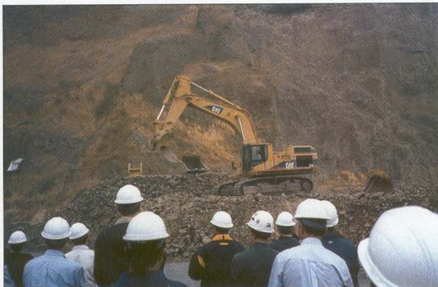
Demonstração na Pedreira Agregua
