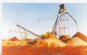
Instalações de Beneficiamento de areia
