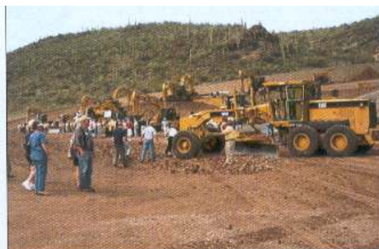
Área de demonstração de equipamentos terraplenagem, construção e serviços
