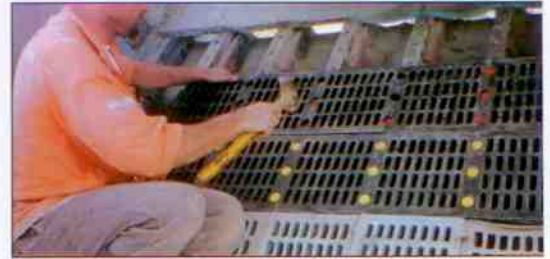
Exemplo de fixação por pino
