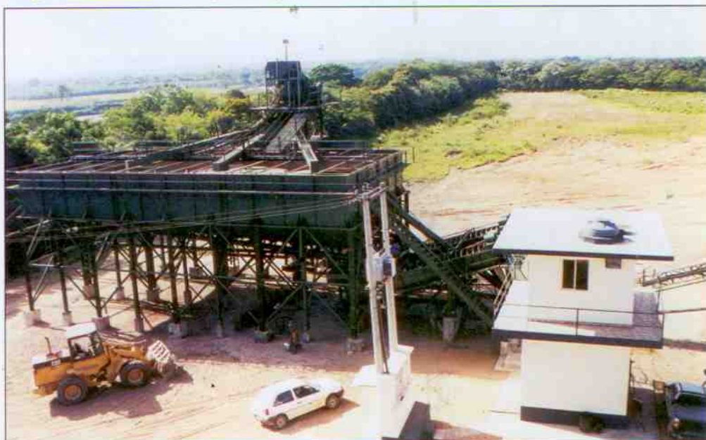
Pulmões com capacidade de 350 metros cúbicos cada, permitindo o armazenamento temporário da polpa descarregada pelos barcos.
