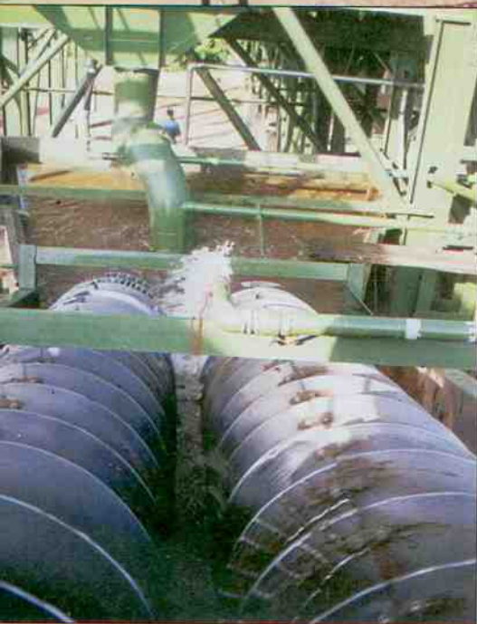
A deslamagem e retirada da matéria orgânica é realizada através de lavadores de rosca.
