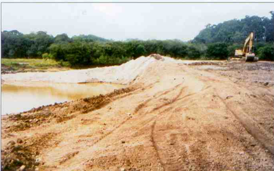
Rebatimento do talude da cava
