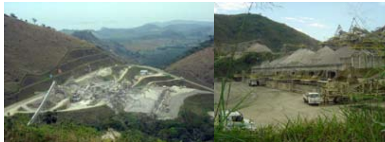
Instalações de britagem da HOLCIM na Unidade Magé
