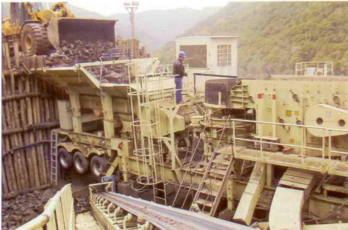
Instalação móvel em operação
