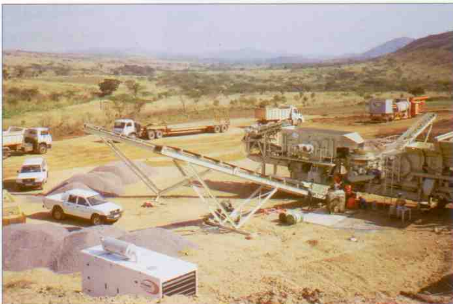
Instalação móvel para obra de rodovia
