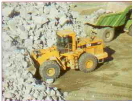
Figura 3 – Processo de carregamento e transporte utilizando equipamentos pesados, Pedreira Itapeti.
