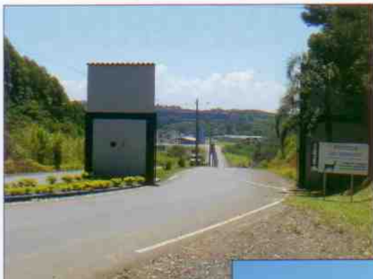
Entrada da pedreira
