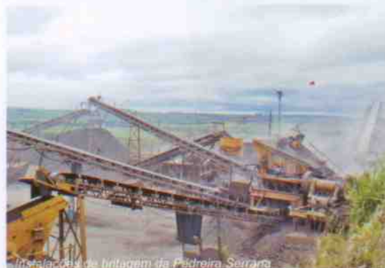
Instalação da britagem da Pedreira Serrana
