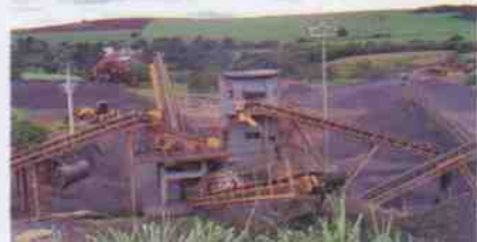
Vista das instalações de britagem da Pedreira Carrascoza
