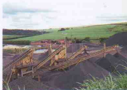
Instalações de peneiramento da Pedreira Carrascoza
