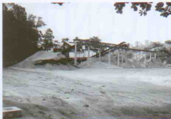
Britagem da Macasa quando estava operando
