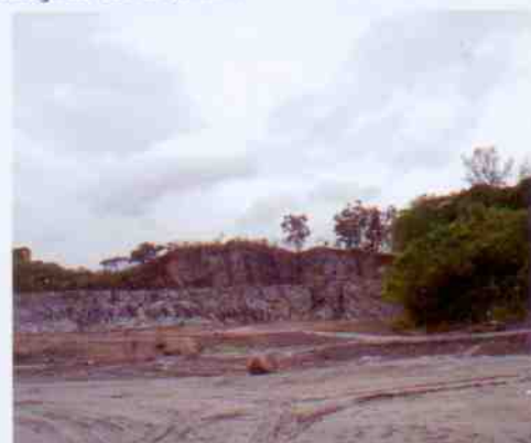
Vista das obras de terraplanagem
