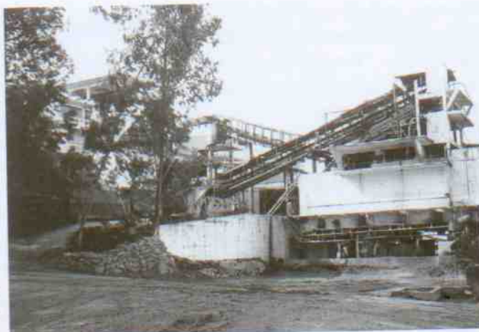
Ex-instalação de britagem
