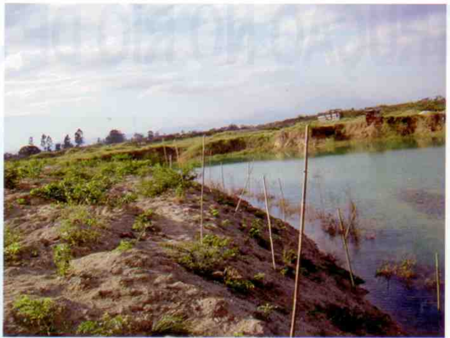
Taludes recuperadas com vegetação
