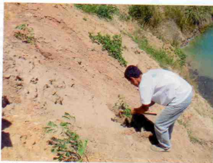
Plantação de mudas em taludes
