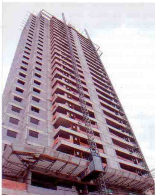
Prédio em Construção na região metropolitana de São Paulo
