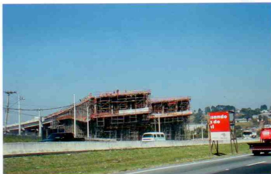
Obras do Rodoanel avançam na Região Metropolitana de São Paulo
