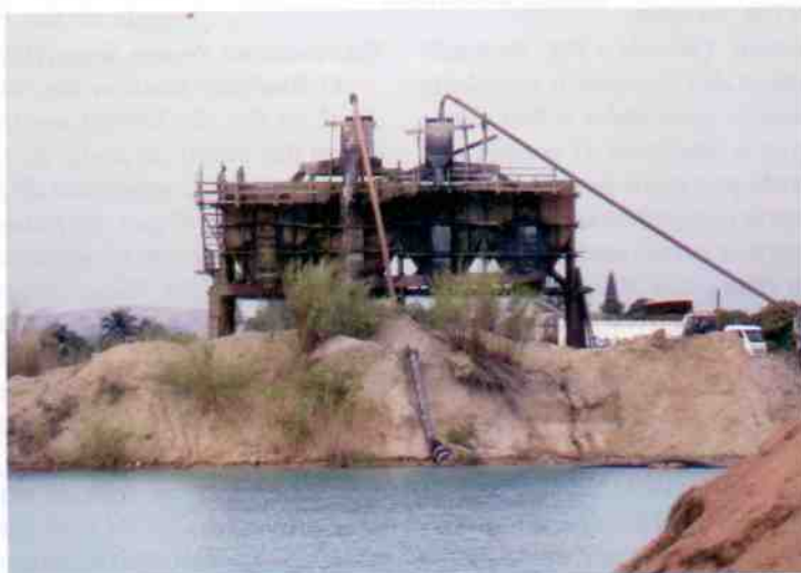
Vista de silos de areia em Seropédica
