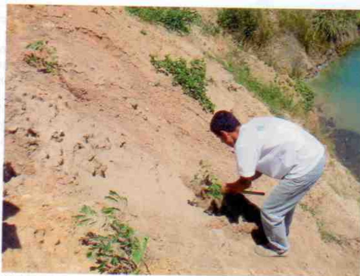
Plantação de mudas em taludes
