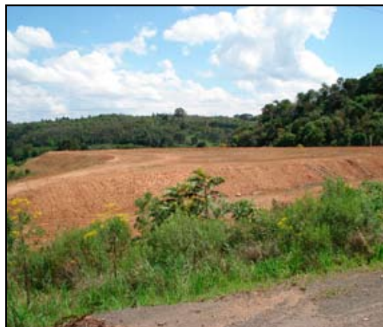
Vista do aterro finalizado
