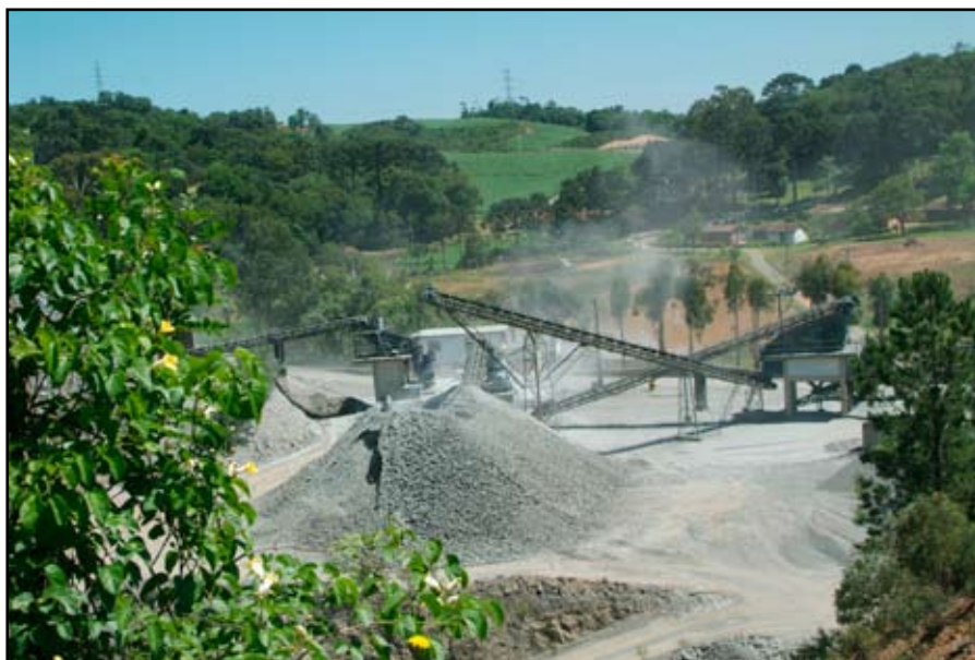
Vista da usina de britagem da Pedreira Central
