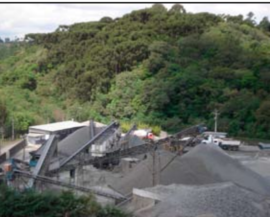
Vista da usina de britagem da Pedreira Central
