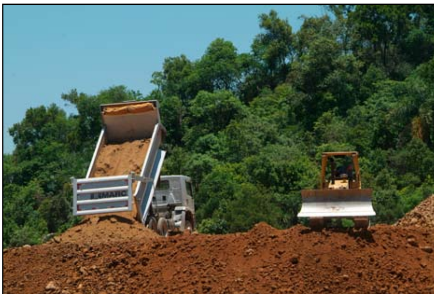
Material da decapagem descarregado no aterro
