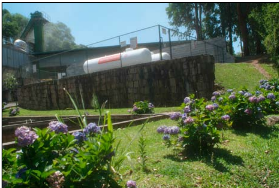
Usina de asfalto – tanque de GLP e piscinas de contenção
