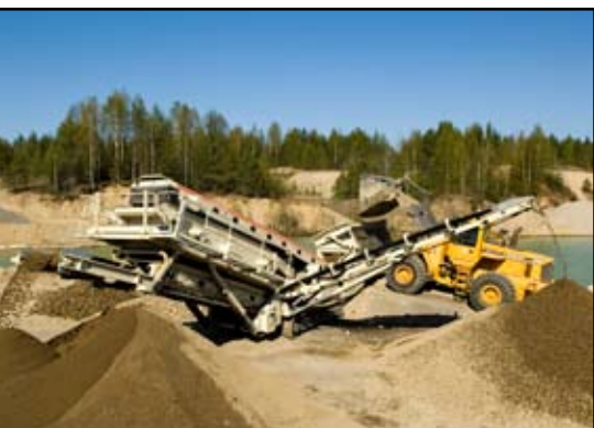
Lokotrack primário trabalhando em reciclagem
