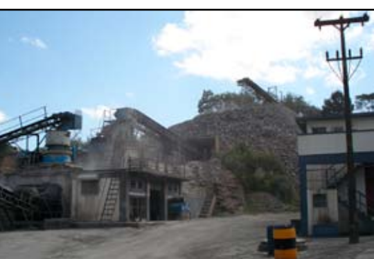
Usina de beneficiamento da Pedreira Central
