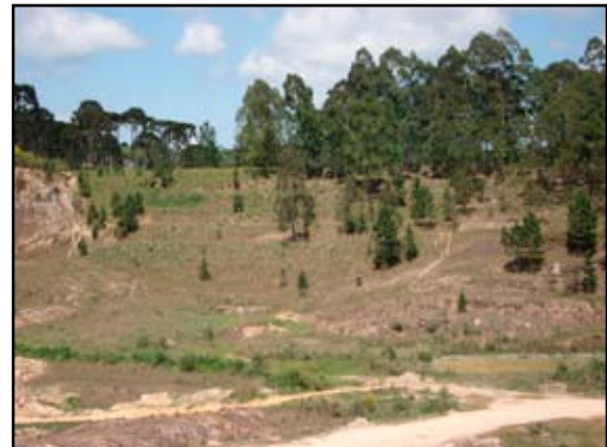
Retaludamento e revegetação da mina
