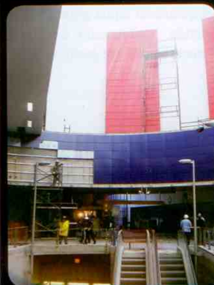
parte interna da Estação Butantã
