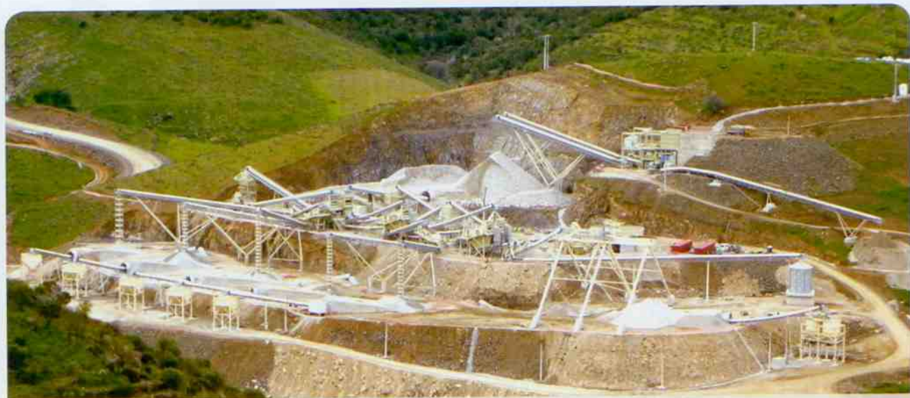
Instalação de Britagem – UHE Baixo Sabor – Construtora Norberto Odebrecht – vista geral
