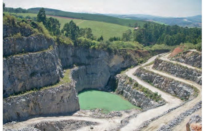
Bacia de contenção das águas pluviais
