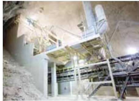
Foto 5 – Instalação de britagem primária de 1.600 t/h na pedreira de La Nueva
