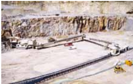
Foto 7 – Instalação de britagem primária móvel e duas correias transportadoras móveis que descarregam material em uma correia fixa que o descarrega na chaminé
