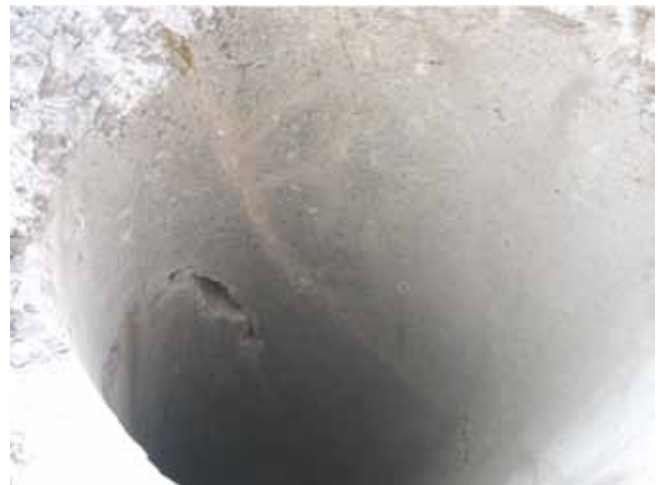
Foto 3 – Aspecto polido da chaminé quando se usa Raise Boring
