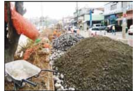
Execução de berço de galeria de drenagem com rachão selecionado e brita graduada, serviço que poderia ser perfeitamente realizado com a utilização de entulho de construção civil em estado bruto ou semi-bruto, com grande economia para a administração pública e enorme benefício para a sociedade. São Paulo, Capital. Foto: ARSantos
