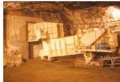
Foto 6 – Instalação de britagem primária compacta – Pedreira de Apario
