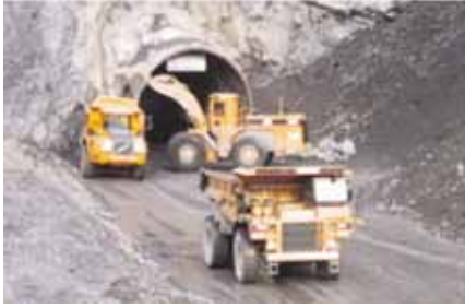
Foto 4 – Galeria curta e carregamento no exterior dela
