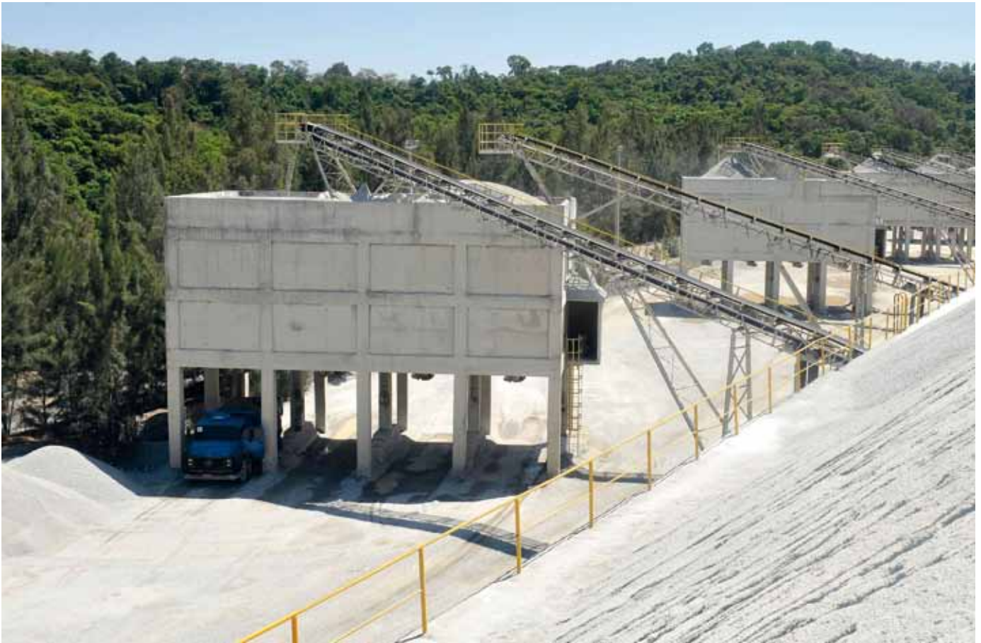
Modelo de eficiência no carregamento de caminhões, os silos permitem controle de volume dos produtos transportados
