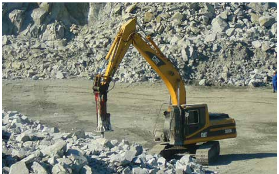
Rompedor montado em uma retroescavadeira
