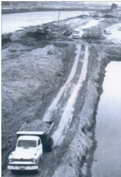
Início das obras na Marginal Tietê (1965)
