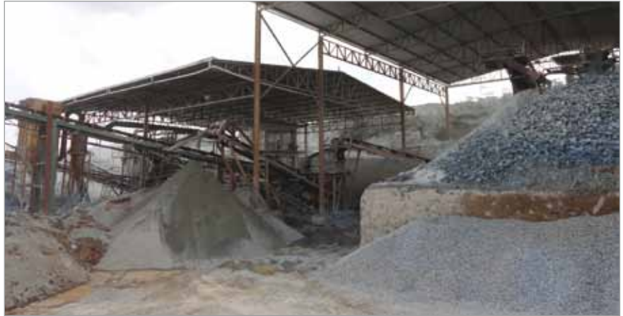
Vista das instalações de britagem.
