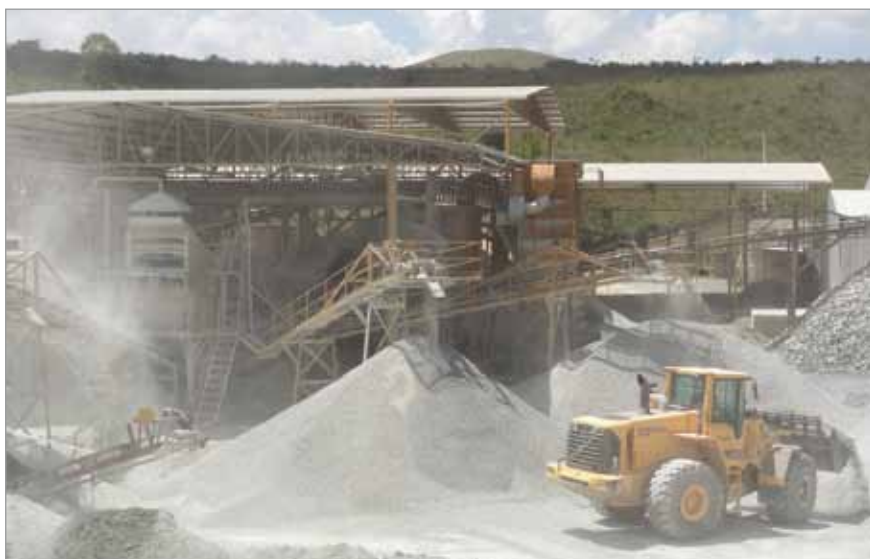
Vista das instalações de britagem.
