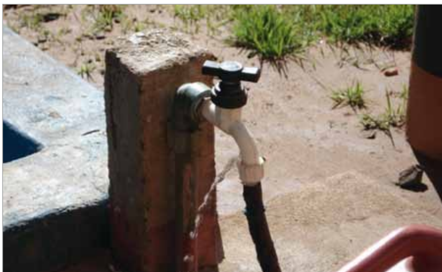
Exemplo comum de desperdício por vazamento observado em planta que opera em 2 turnos.
