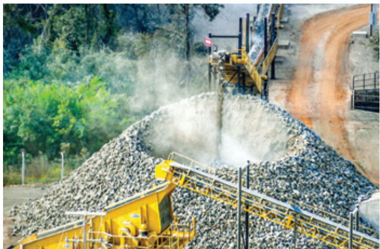
Vista das instalações de britagem.
