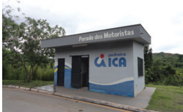
Área reservada para motoristas que transportam pedra britada.
