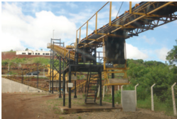
Montagem das instalações na pedreira nova.
