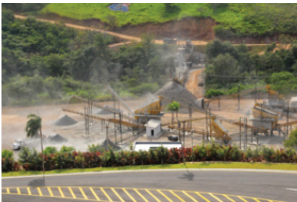
Vista das instalações de beneficiamento da brita.
