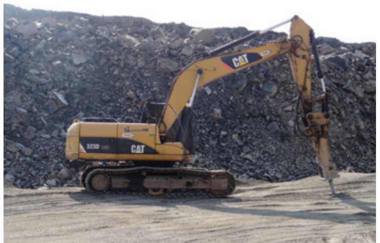
Martelo para reduzir tamanho de matacões acoplado a escavadeira.
