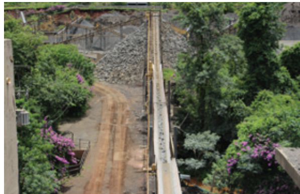
Vista das instalações de britagem.
