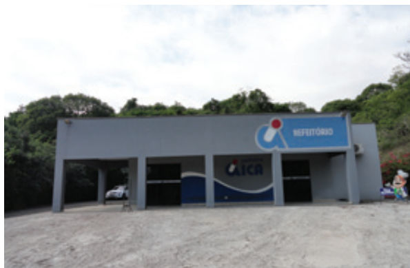
Refeitório para funcionários.
