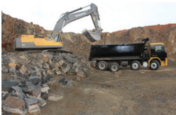
Escavadeira trabalhando sobre pilha no carregamento da rocha.
